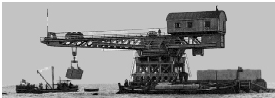
Het laten zakken van een blok naar de juiste positie aan het uiterste einde van een golfbreker.
