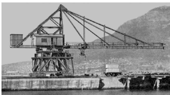
Deze Blocksetter is gebouwd door Stothart & Pitt Ltd. voor gebruik in de Table Bay, Capetown, SA.
