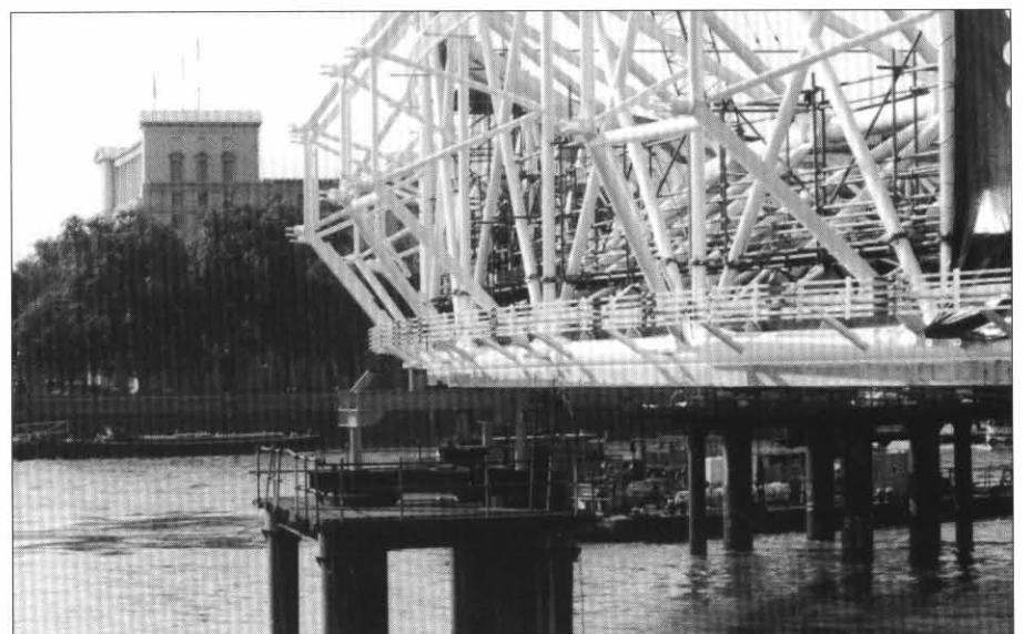
Afbeelding 7. detail, duidelijk is hier de complexe constructie te zien
