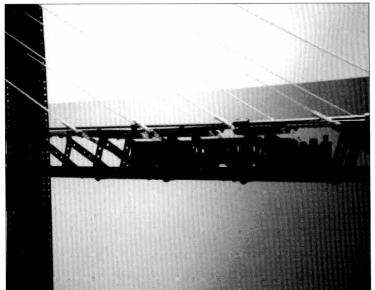
Een staalconstructie aan de tuien draagt het treindek.
